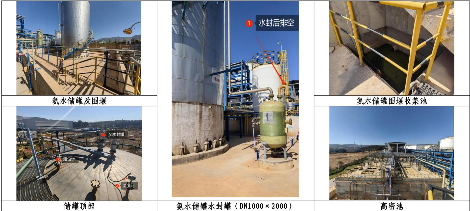
氨水储罐增加水封罐措施。正常状态下，氨水储罐大小呼吸引起的无组织逸散气体通过气压平衡管至水封罐，通过水吸收后放空。
