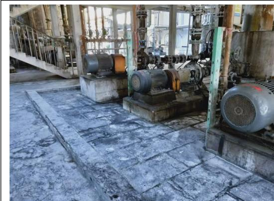
酸泵设置围堰及防腐防渗
